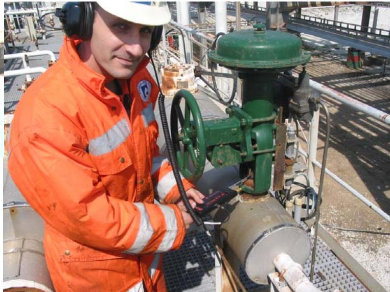
Detección de escape interno con el PS-2100 en una válvula LPG
